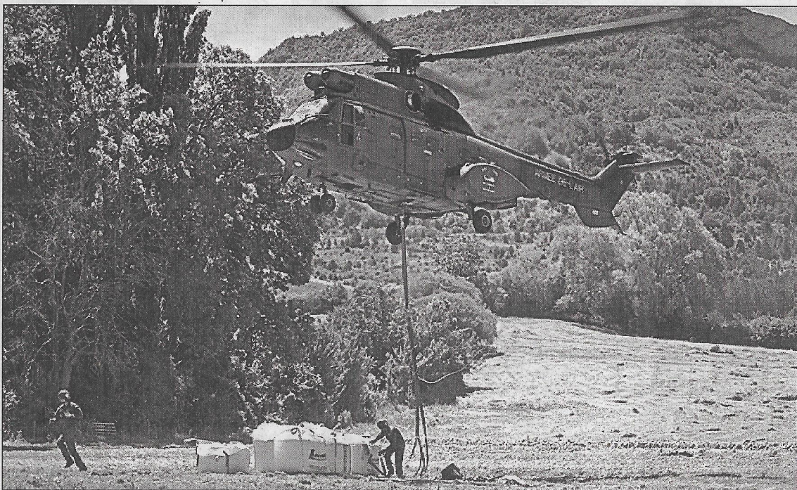
La tour étant inaccessible aux véhicules, c'est par la voie des airs que les porteurs du projet ont décidé de transporter les 12 tonnes de matériels.
